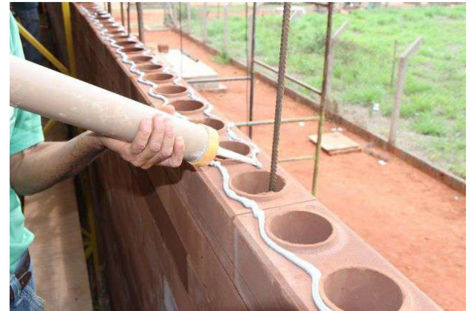
Figura 4 - Construção com tijolos ecológicos
