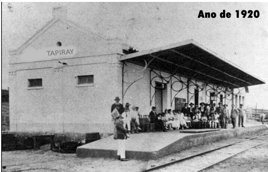
Estação Ferroviária de Tapiraí
