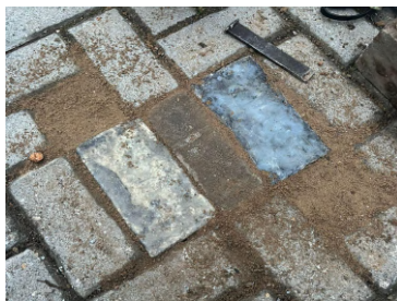
Figura 35 - Pavers ECOPLASF implementados a garagem
