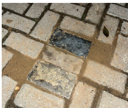
Figura 36 - Pavers implementados após o tráfego de veículos
